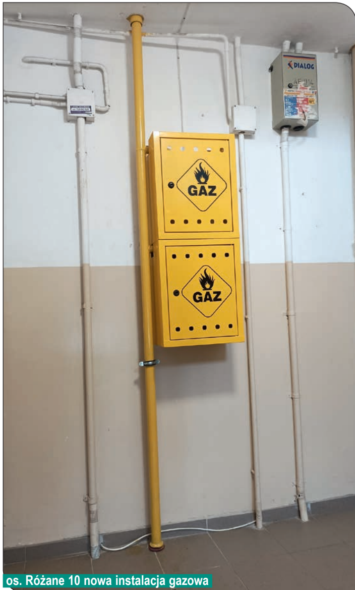
ul. Budowlanych nowa szafa licznikowa
